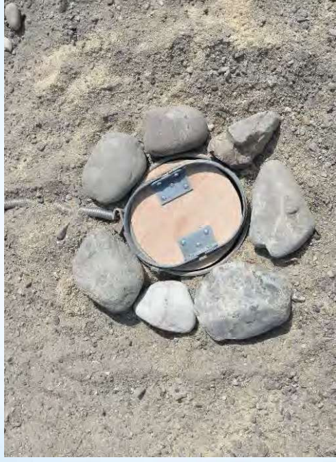
⑬ 踏み板と石の間の隙間（黄色箇所）× くなる（石が丸すぎる）×
