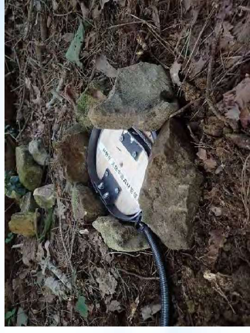
⑧ 塩ビ管の上に踏み板をセット
