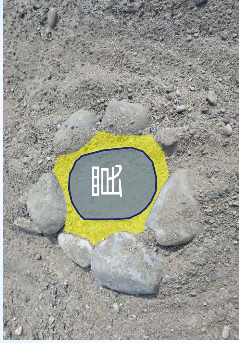
⑭ 隙間が大きいので、空はじきが多
