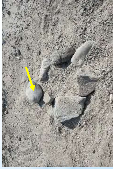
⑬ 踏み板と石の間の隙間（黄色箇所）× くなる（石が丸すぎる）×
