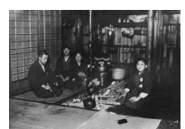
不動谷従業員宿舎内 の様子1
