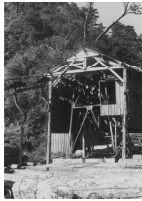
索道起点機械小屋 (延長962m)
