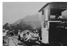
軌道船津線起点付近
