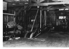
索道起点機械小屋内部
