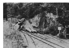
軌道トロ-を利用した運材3 (岐点付近)
