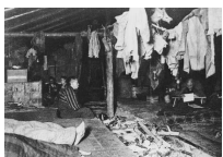
不動谷従業員宿舎内の 様子2
