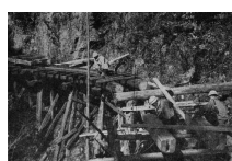
軌道栈橋の修復状況(S40頃)
