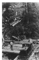
集積した材を軌道トロへの積込作業
