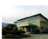
尾鷲森林経営センター (S46建設)
