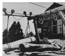
二ノ俣索道起点機械小屋の様子
