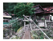
桃の木小屋1(S15建設)
