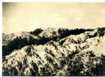
(昭和初期) 奥側は施工後
