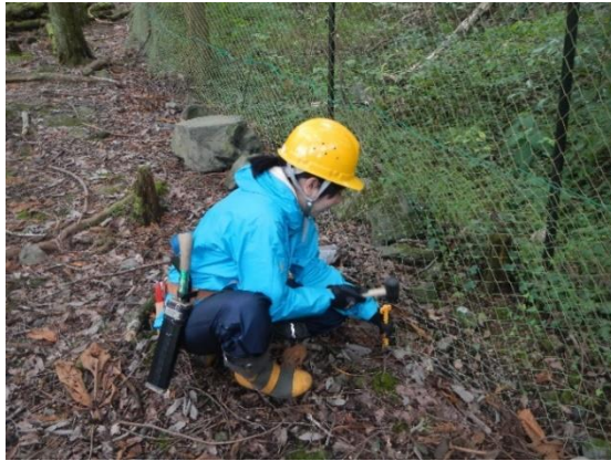
【写真-4 防鹿柵の点検・修理】
