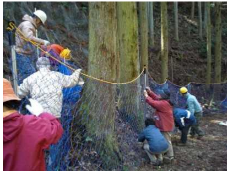
写真5 シカ防護柵設置
