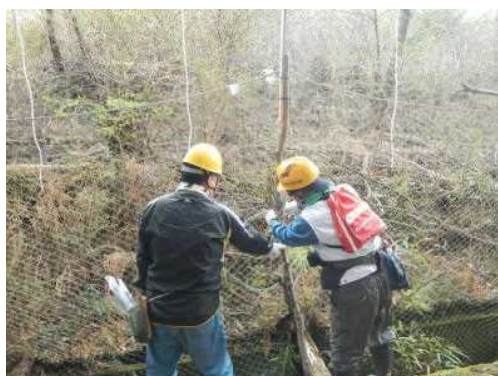
シカネットを修繕
