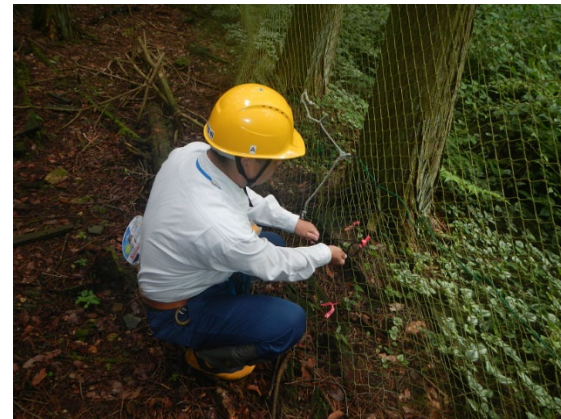
【写真-7 防鹿柵の点検・修理】
