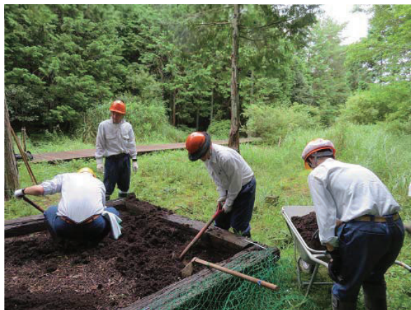
古い土の取出し
