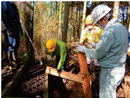
【写真-21 テキサスゲート補修作業】
