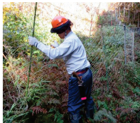
【写真－5 防鹿柵の点検・補修】
