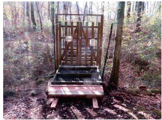
【写真-22 テキサスゲート補修後】
