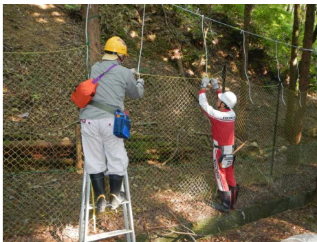
飛び越え防止用ナイロンロープの設置
