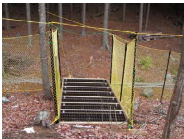
完成した防鹿柵及びテキサスゲート
