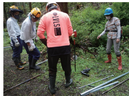
作業風景(案内穴を空ける)
