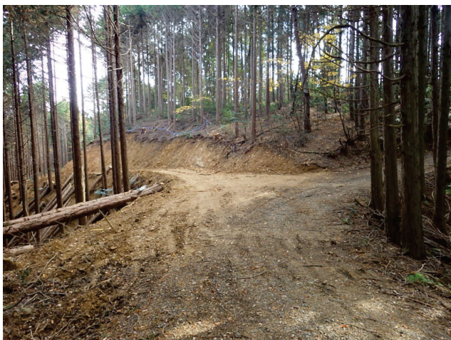
第1期 国有林作業道から接続する路網整備
