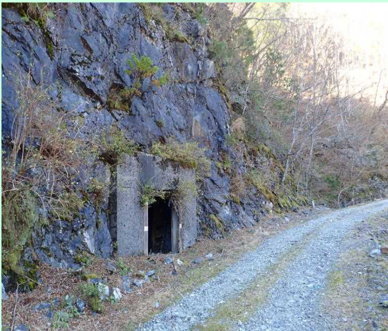
写真4 岩肌をくりぬいた苗木保管庫
