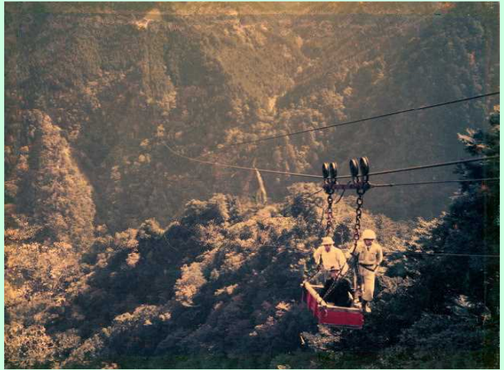
写真5 人運搬用の荷台での人員輸送
