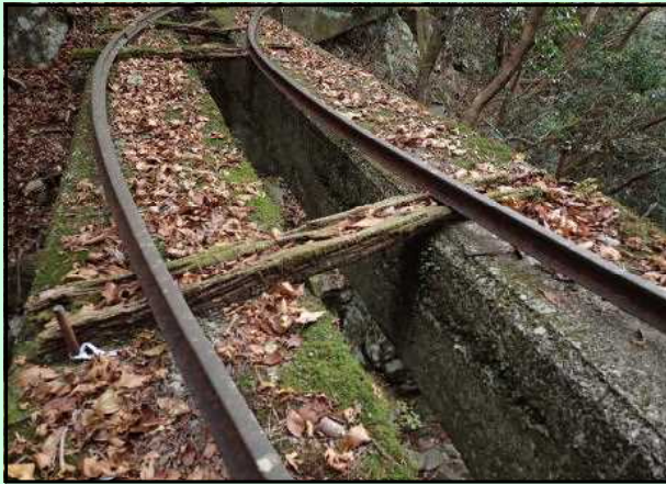
写真8 水越谷線跡に遺るレールと枕木
