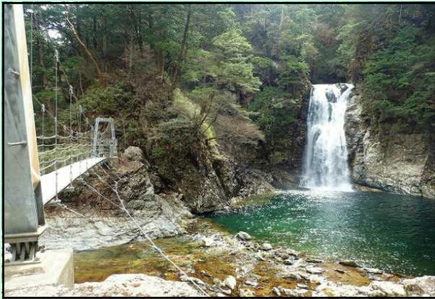
写真4 春の大杉谷 堂倉滝と堂倉吊橋
