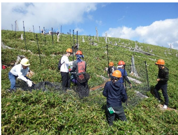
植生保護柵設置作業（大杉谷）
