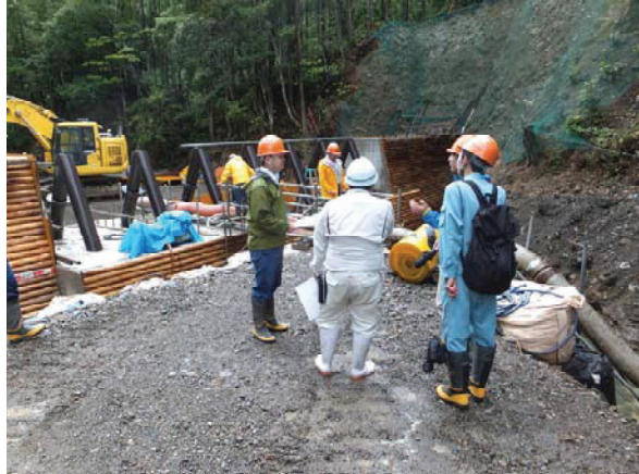
治山工事現場の見学
