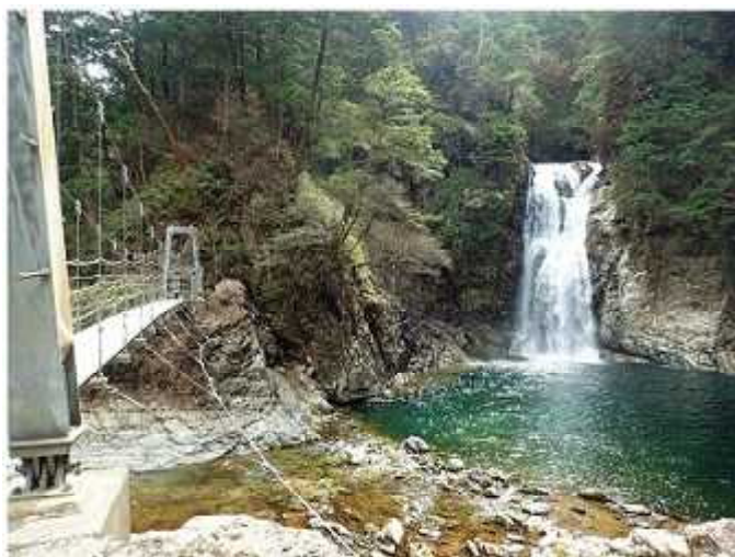
写真4 堂倉滝と堂倉滝吊橋
