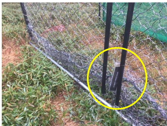
図 3-3 法令上定められた標識の取り付け
