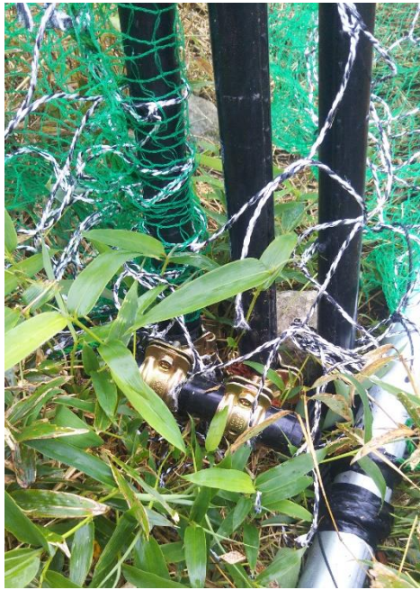
図 3-25 隙間を防ぐための支柱の設置
