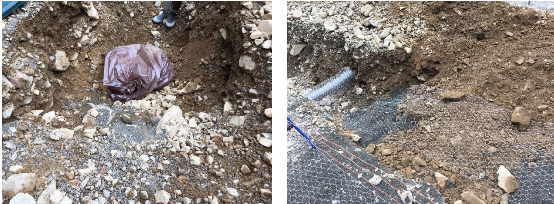
図 3-9 生分解性ガスバリアシート、ワイヤーメッシュを使用した埋設
