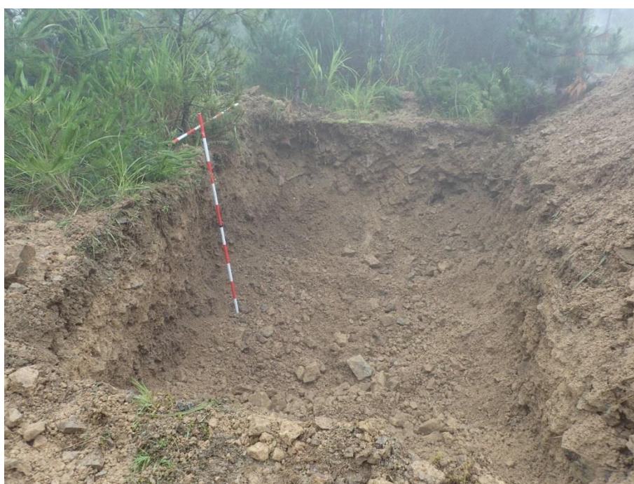
写真 20 埋設穴の掘削状況
