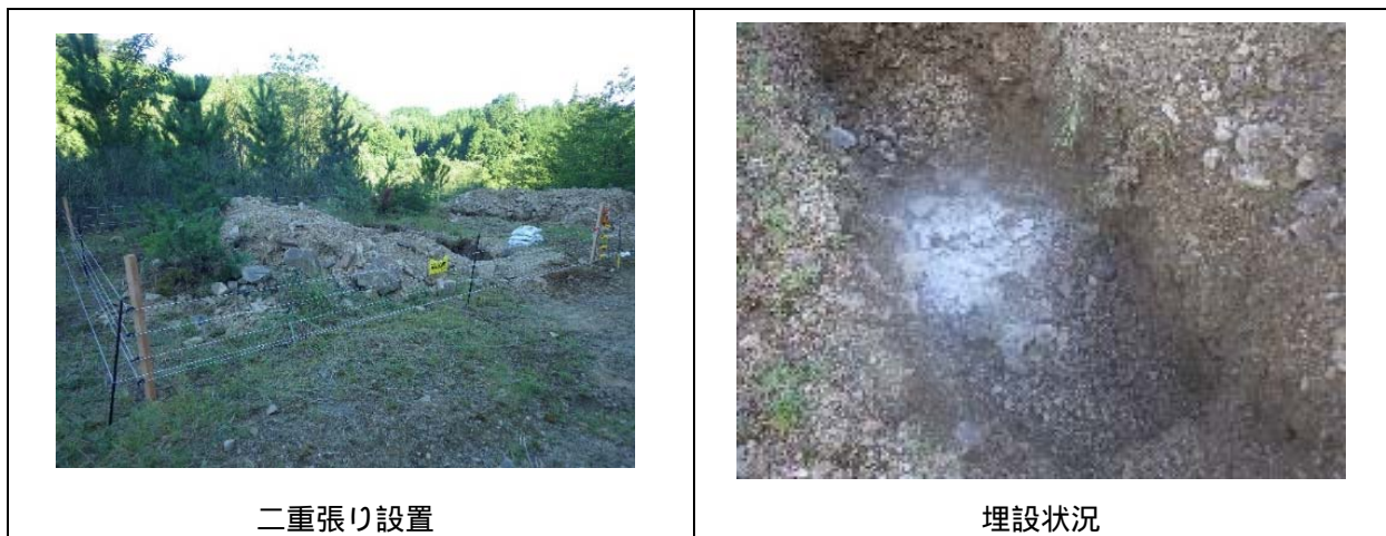
図 18 埋設穴の状況
