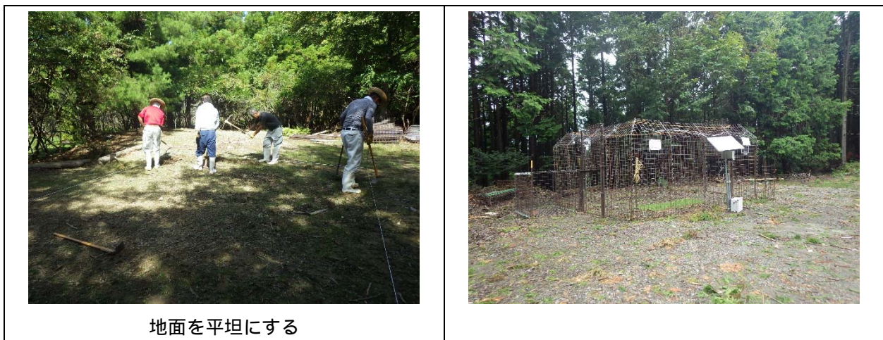
図 13 囲いわなの設置状況
