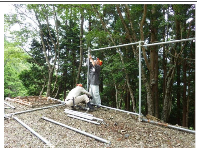
作業1 単管の組み立て①
