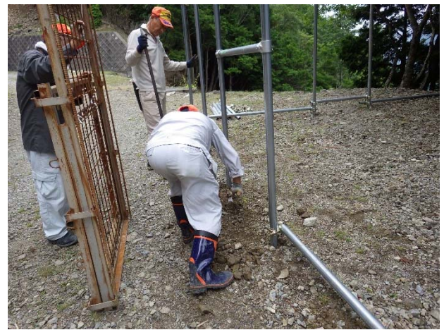
作業2 落とし扉の設置
