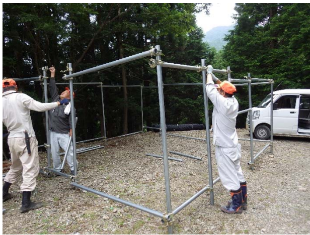
作業1 単管の組み立て②
