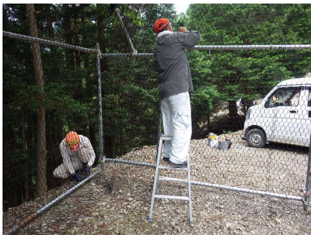
作業3 PK ネットの設置
