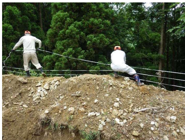
ワイヤーの設置
