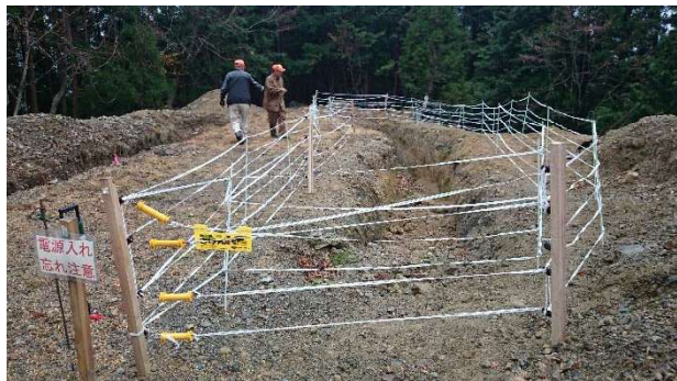
二重張り設置①
