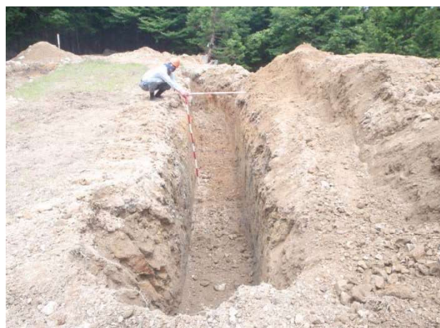
掘削後 (埋設穴)
