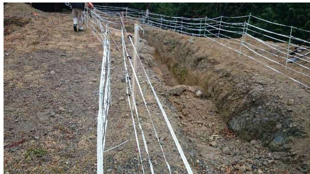
二重張り設置②
