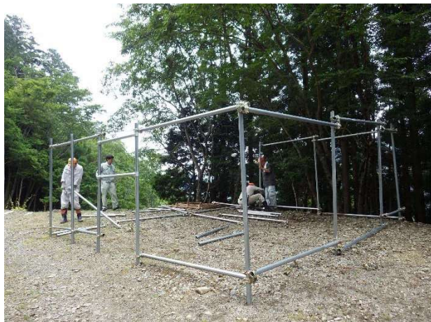
骨組みの組み立て作業
