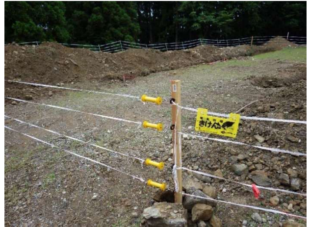
設置後（出入口）
