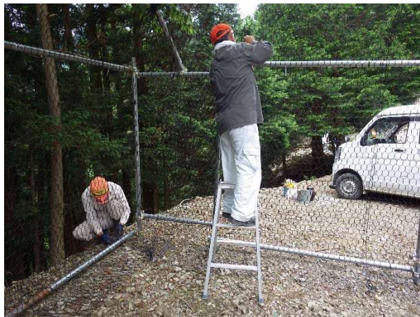
スーパーPK ネットの設置
