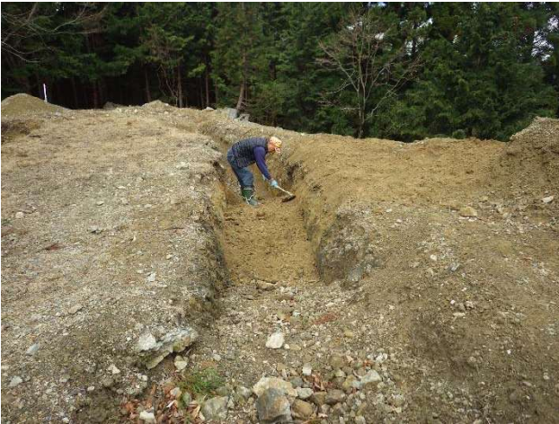
土入れ作業風景
