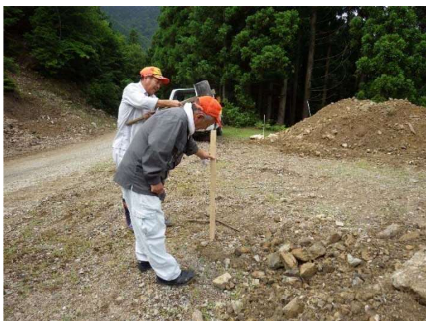
杭の打ち込み
