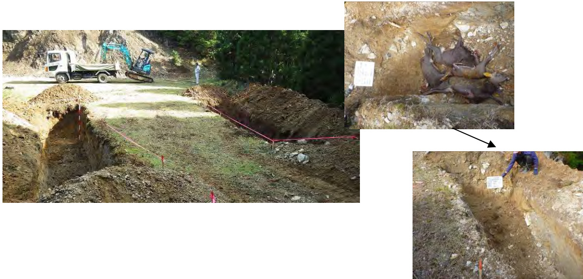
写真 3 埋設穴の設置状況
