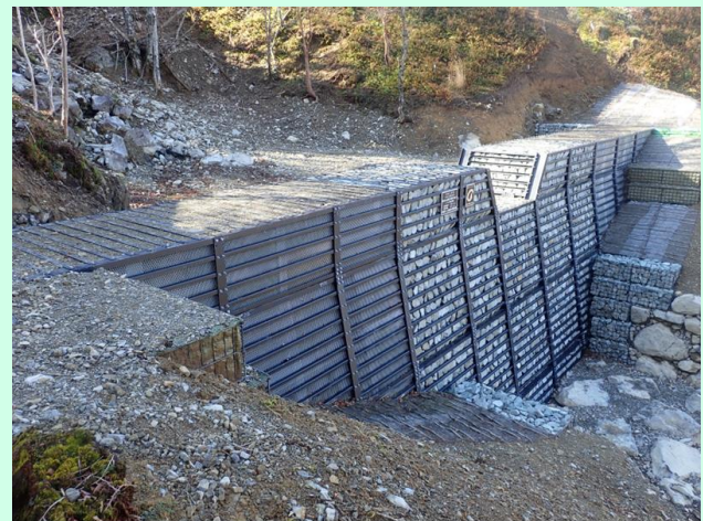
写真6 鋼製梓谷止工
