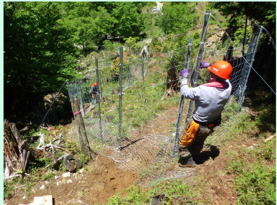
写真4 植生保護柵設置の様子
