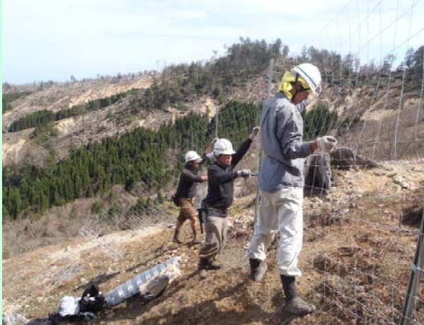
植栽に不可欠な防鹿柵の設置
