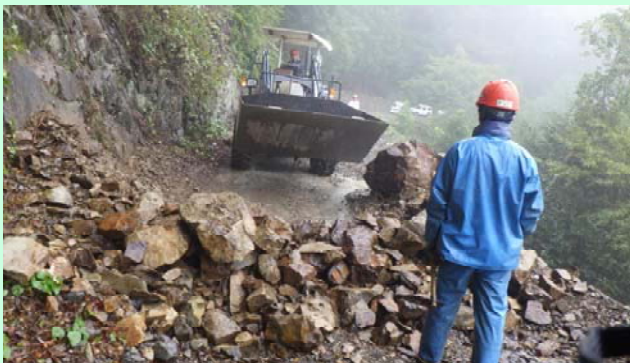
台風によって落石が発生し、行く手を遮られました
