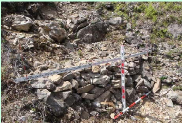
現地の石を活用した空石積工
