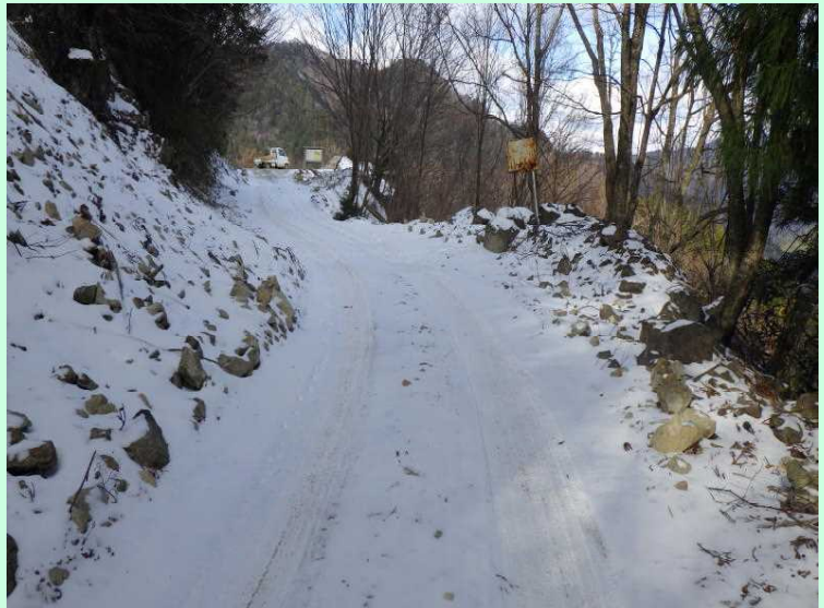
雪道を通して間伐作業が進められています。
