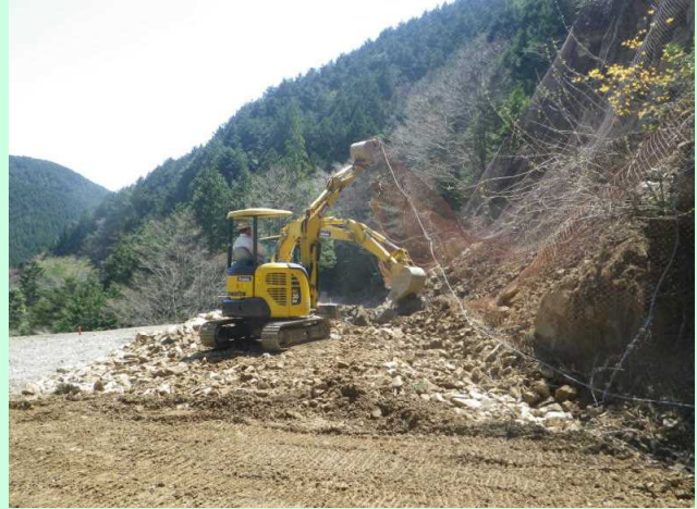
通行を確保するための崩土除去
