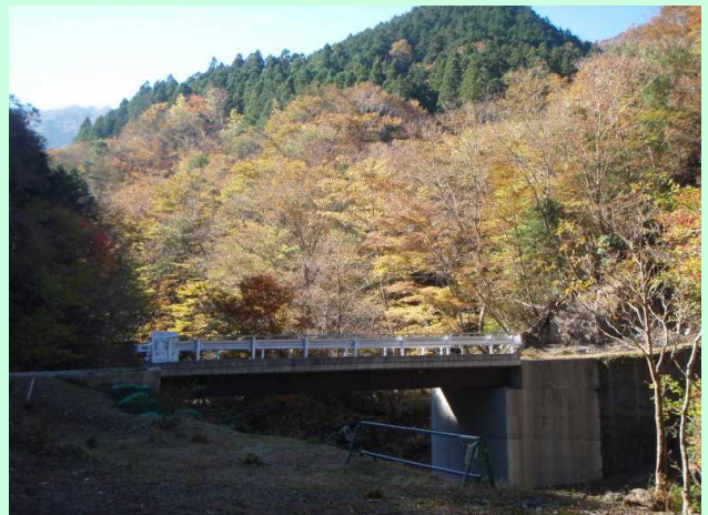
平成24年に復旧した加茂助橋。
