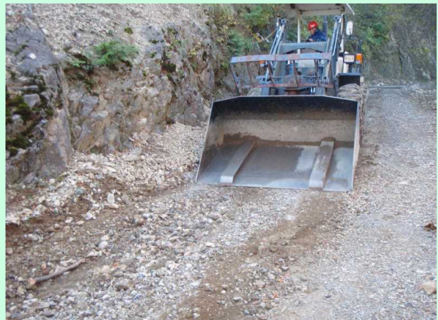
洗堀された箇所を埋めてトラックが通れるようにしています
