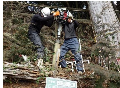
木杭打設の状況（京都市 安祥寺山国有林）
