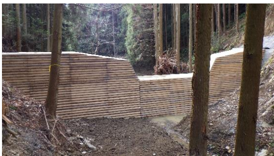
丸太残存型枠の設置 （安祥寺山国有林）
