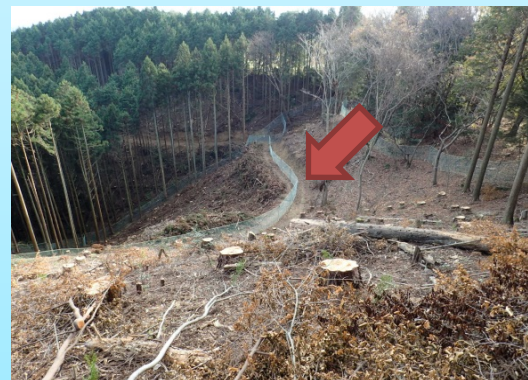
仕切線の設置
