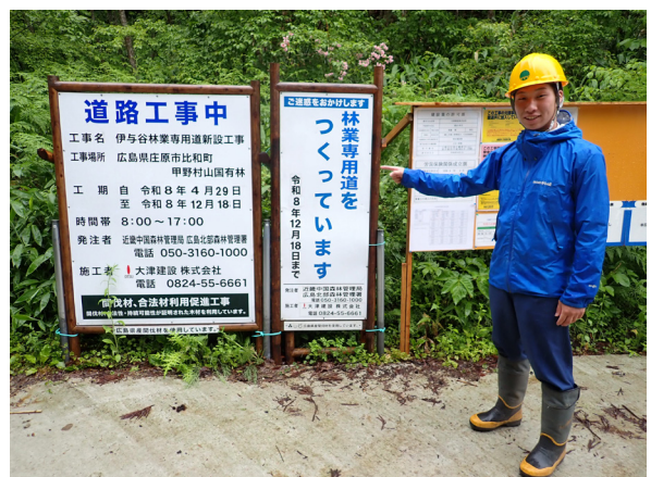
林業専用道新設工事の監督業務を実施しています。
