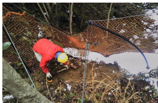
防護柵の土砂撤去
