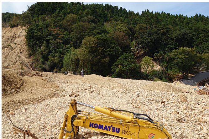
(写真 - 3 : 大谷町の崩壊土砂)
