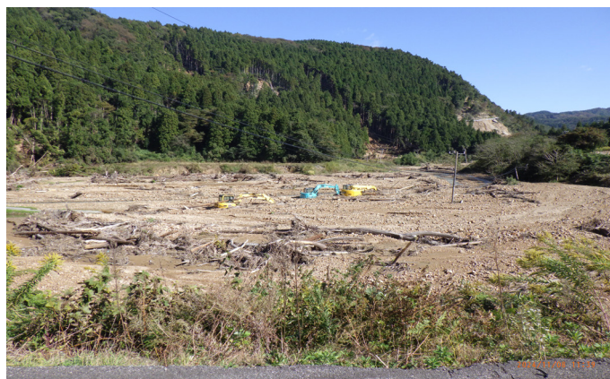
(写真 - 2 : 被災後のヘリポート)
