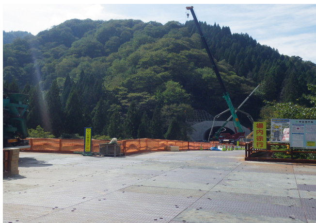
中部縦貫道トンネルと入谷国有林
