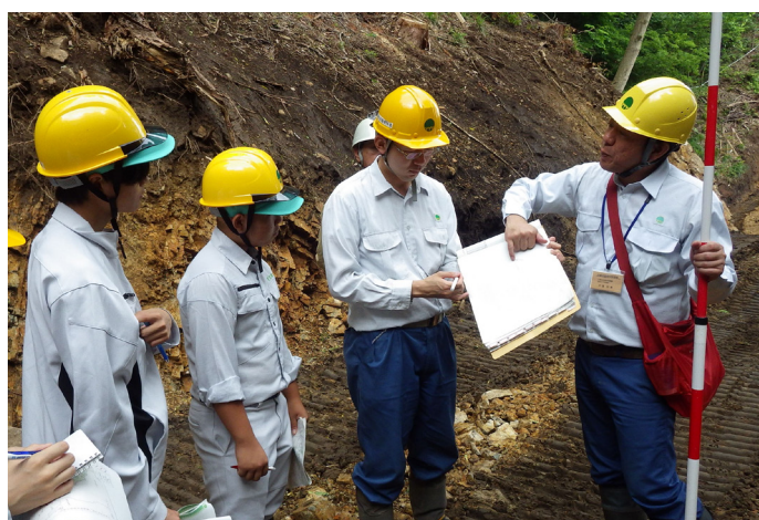
林道新設工事の視察
