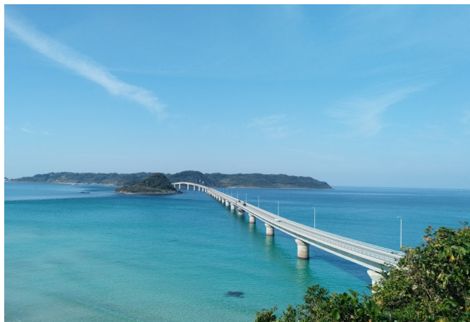
角島大橋【下関市】
