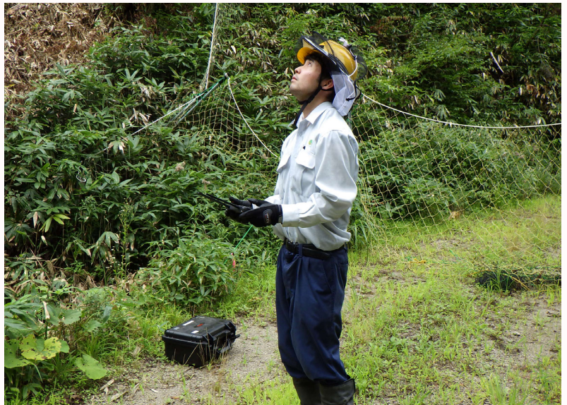
ドローンを使用した防護柵点検の様子
