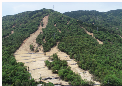
(R2.06) 災害復旧工事後
