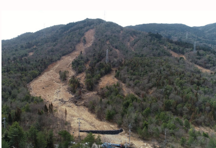
(H31.03) 応急対策工事後【東広島市】
