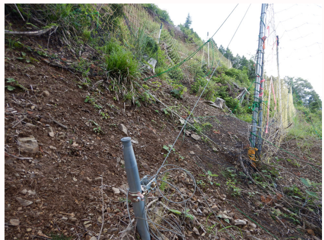
テンション機材と施工状況
