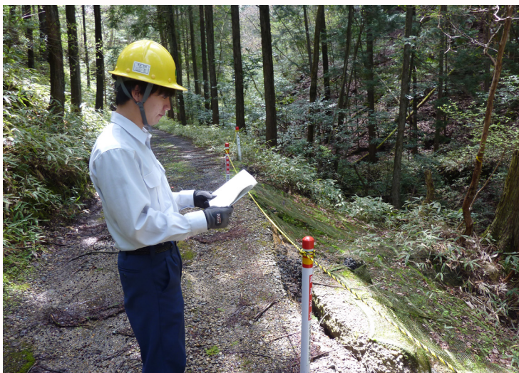
崩壊地（事業地）の確認中
