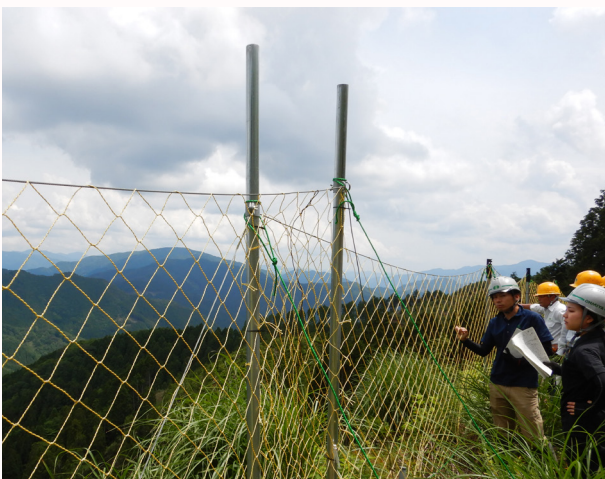
ネット継ぎ目と施工状況
