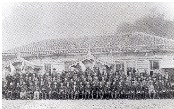
日原小林区署庁舎竣工式（明治43年）
