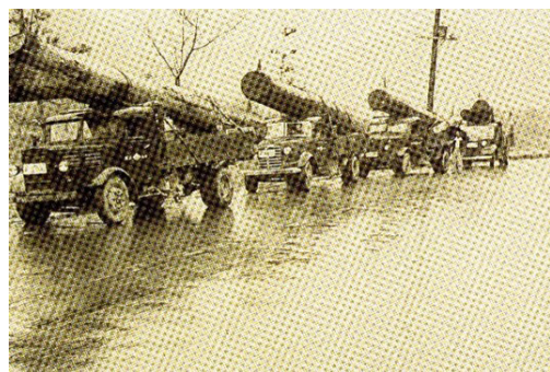
トラックで運搬されるケヤキ原木
