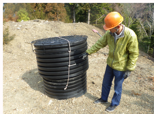
埋設処理のための大型排水管
