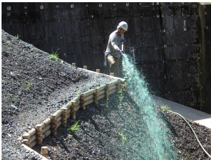
土壌藻類の吹付状況（五百瀬 2 号地溪間工事）
