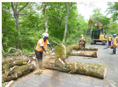
作業中（伐倒・搬出）
