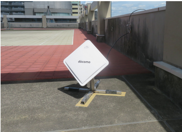
外部アンテナ設置(屋上)
