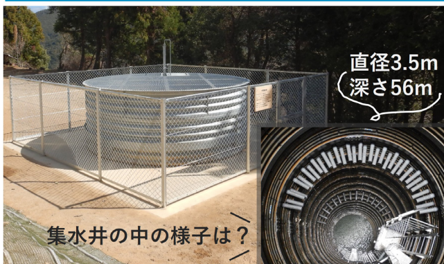
集水井工施工地（上秋津区域）
