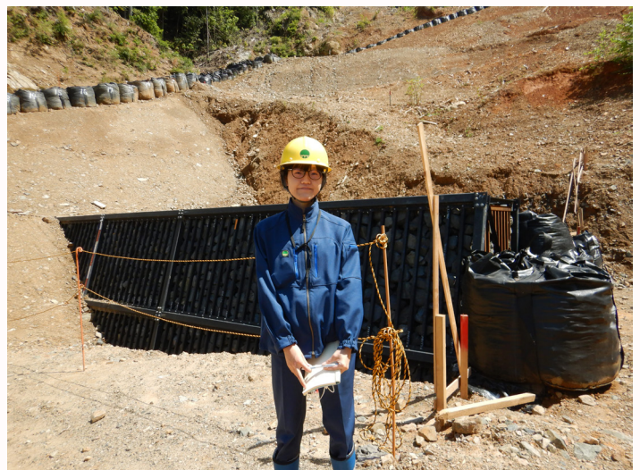
治山現場でのOJTです
