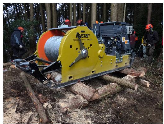
設置された集材機
