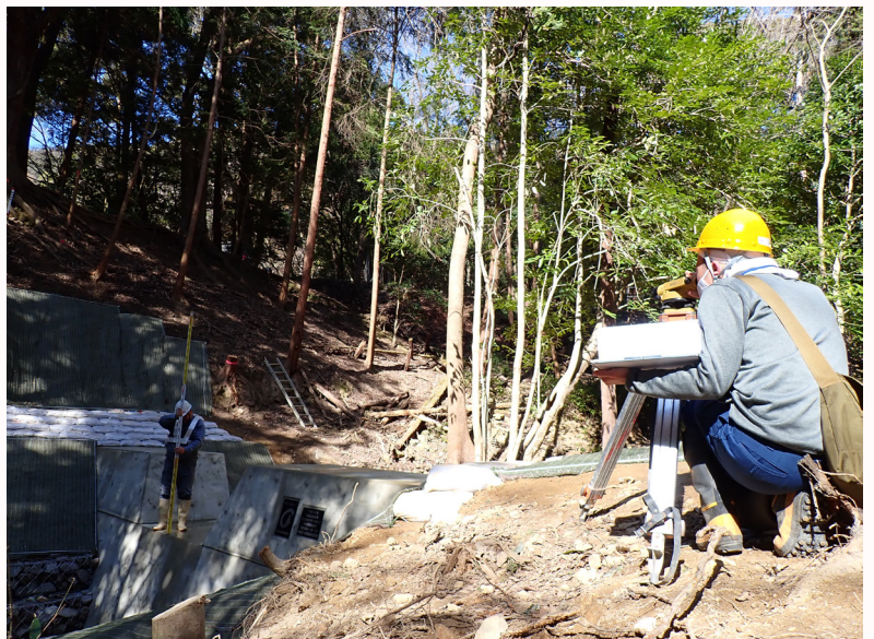
ダムの完成状況を確認しています。
