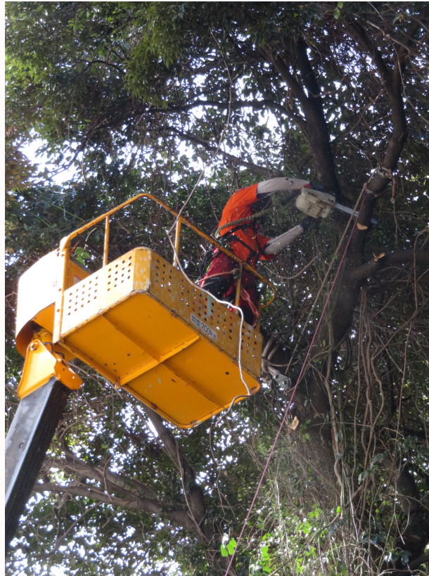
高所作業車を使用した枝払い作業
