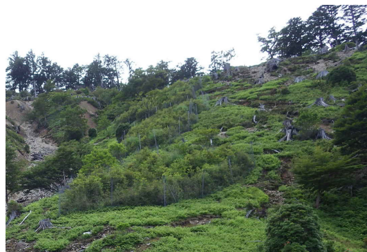
平成 30 年度防護柵、植栽実施箇所
