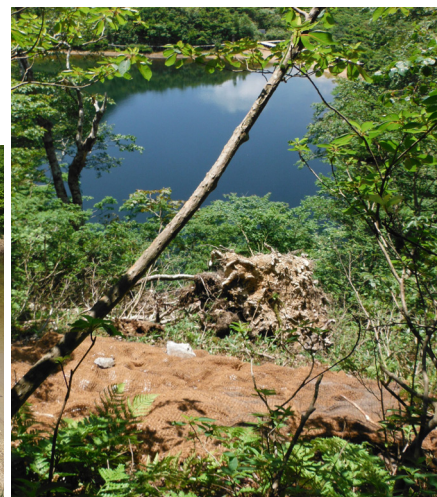
職員により設置した土壌流入防止対策 (ヤシマットの伏工)
