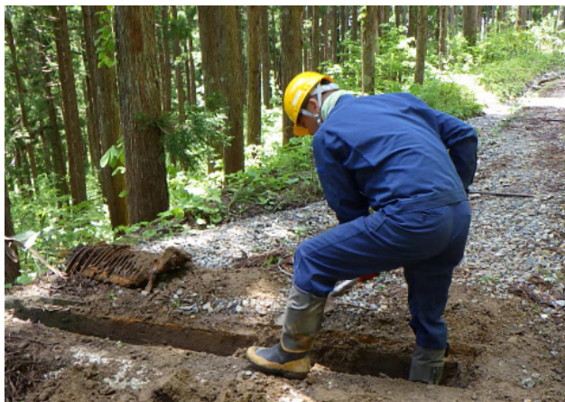
林道の横断溝の清掃
