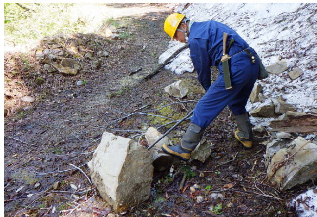
林道上の落石の除去
