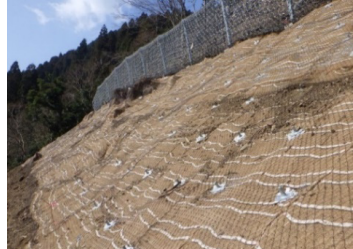
【斜面安定対策工】
