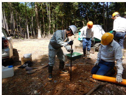
就業体験(林道ゲート設置)の様子
