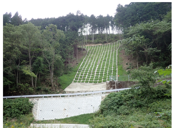
大造山国有林災害復旧工事
