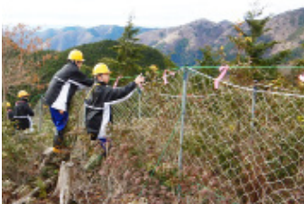
シカ防護柵の修理作業
