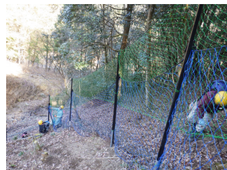
シカ防護柵の点検・修理
