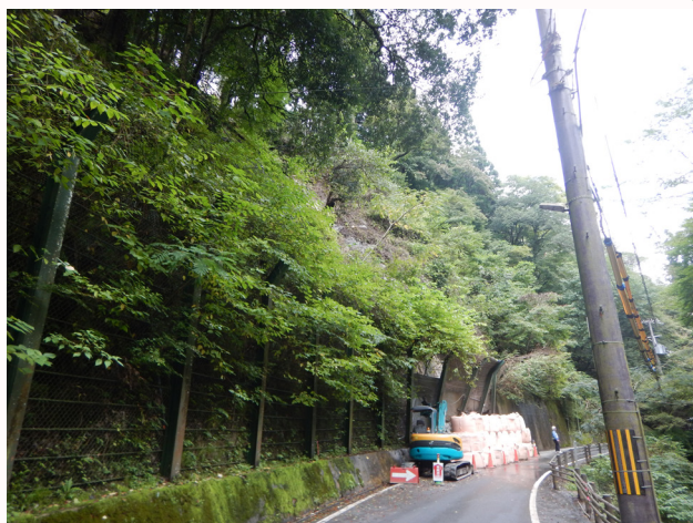
応急対策後の状況
