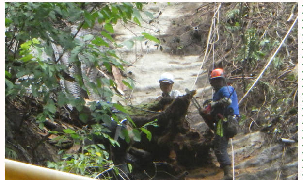
根株等の吊り下ろし作業
