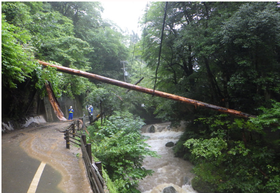
被害直後の府道の状況（貴船山国有林）
